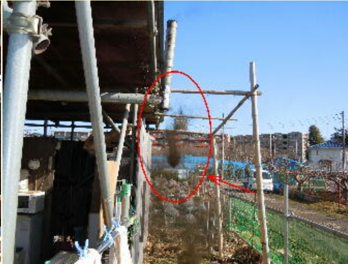
ブラシを刺し込むと、煤がガバッと(赤丸)落ちる。
